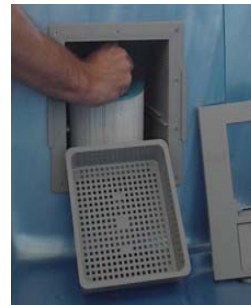
3/ Retire la bandeja desenrosca el filtro y después retirarlo
